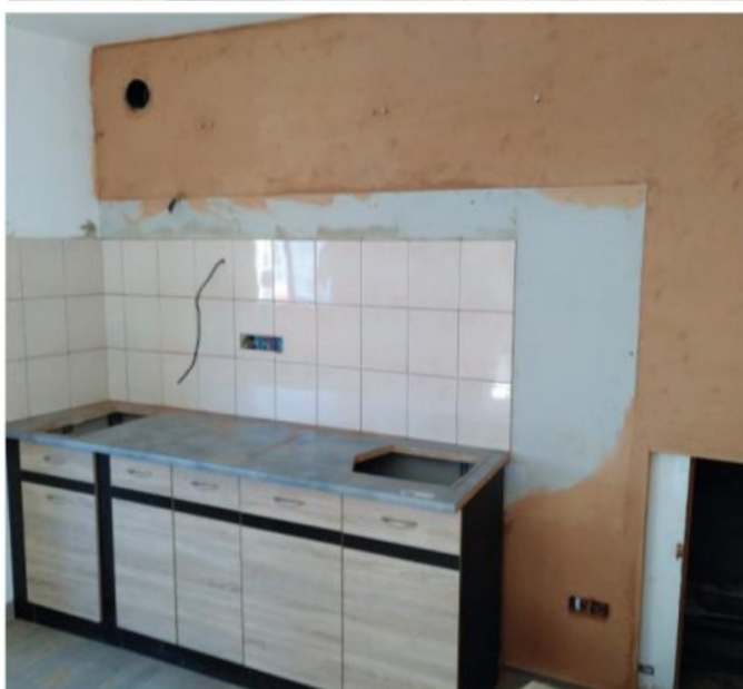
Figure 2: Pose de blocpailles du Village pour l'isolation extérieure sous véranda. Figure 3: Complexe isolation vrac de paille, finition enduit Terre du Luberon
